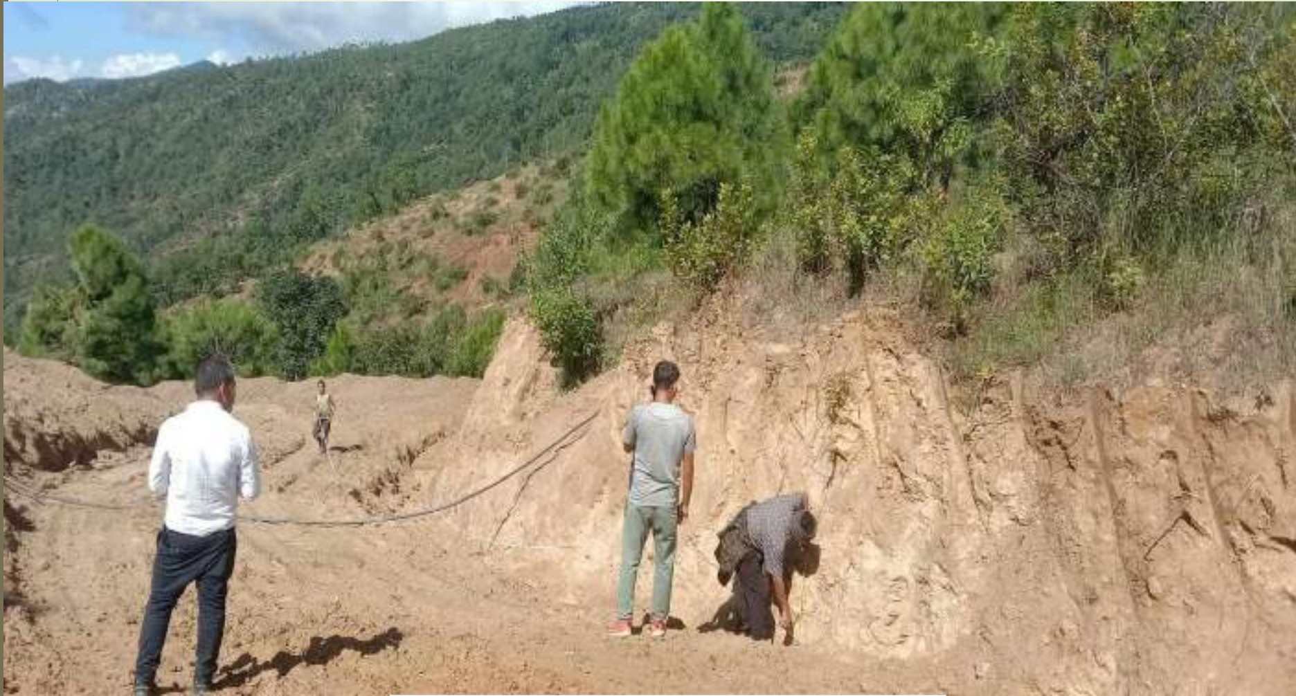
नयाँ सडक निर्माण
