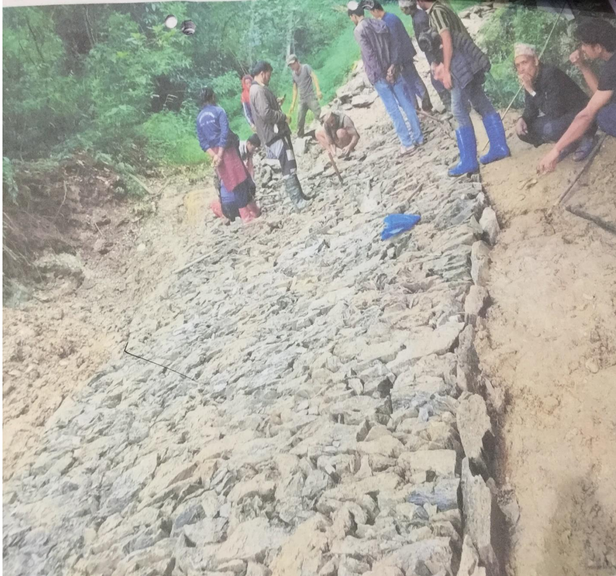
वडा नं-६-छेपेखोला भुलभुले सडक नाली कटान तथा मर्मत
